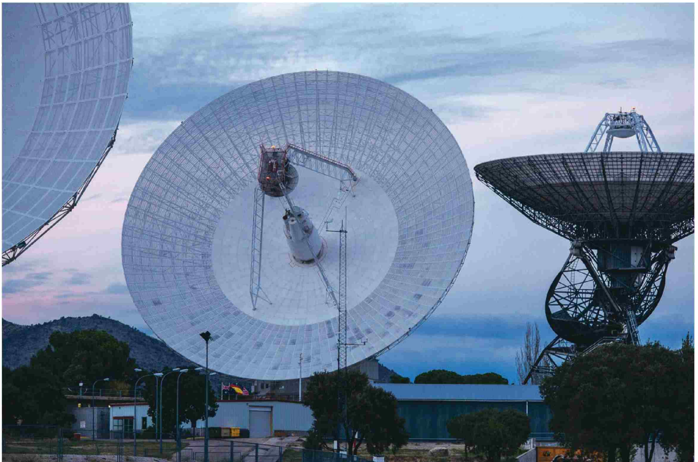
Radijske antene DSN so postavljene v Kaliforniji, Madridu in Canberri. Tako je zagotovljena stalna komunikacija tudi z najbolj oddaljenimi sondami v vesolju.
